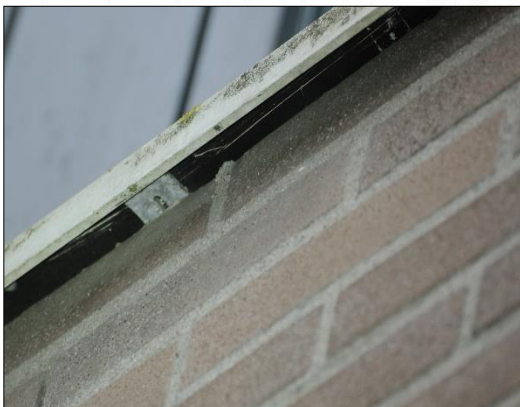
Afbeelding 3: Ligging van de muur (boven: gele contour) met openingen (onderste rij) die gebouwbewonende vleermuissoorten toegang naar geschikte ruimtes in de spouw bieden (Foto's: Laneco, 2021).
